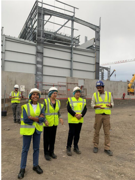
Visite du chantier du projet Run'Eva (La Réunion)
