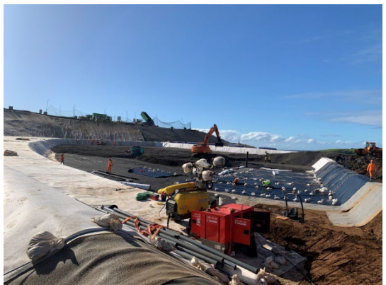
Surélévation en cours de l'ISDND de Sainte-Suzanne (La Réunion)
