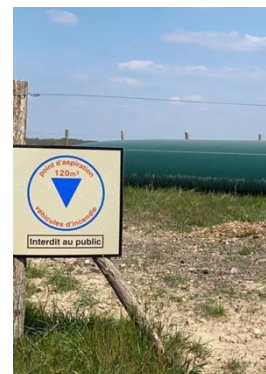
Source : bêche incendie à Cangey (37)
