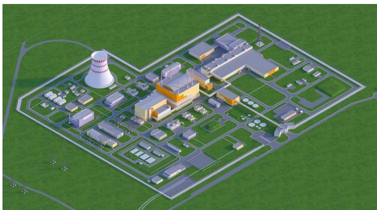
Vue générale du complexe de démonstration du réacteur Brest-OD-300 en construction à Tomsk (Source : Tvel)
