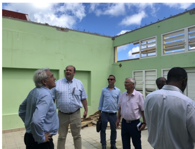
Visite du chantier d'une école avec les services de l'éducation du rectorat et de la collectivité
