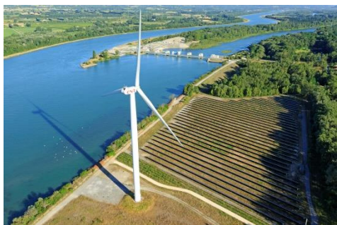
Barrage, parc éolien et parc photovoltaïque du Pouzin (Ardèche) © CMOirenc/médiathèque CNR.
