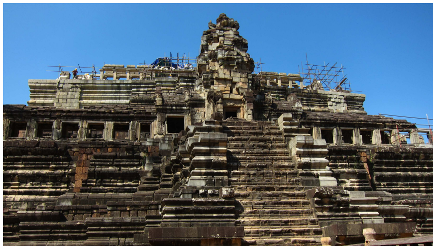
Chantier du temple du Baphuon
