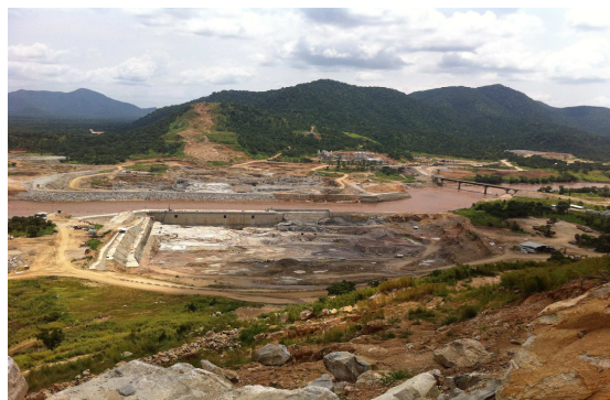
Chantier de construction du barrage « Grande Renaissance » au Nord-Ouest de l'Éthiopie
